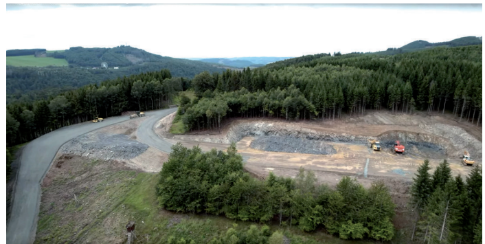
Bild 5: Geländeenivellierung für 1 WKW 3,45 MW bei Mannstein 8
