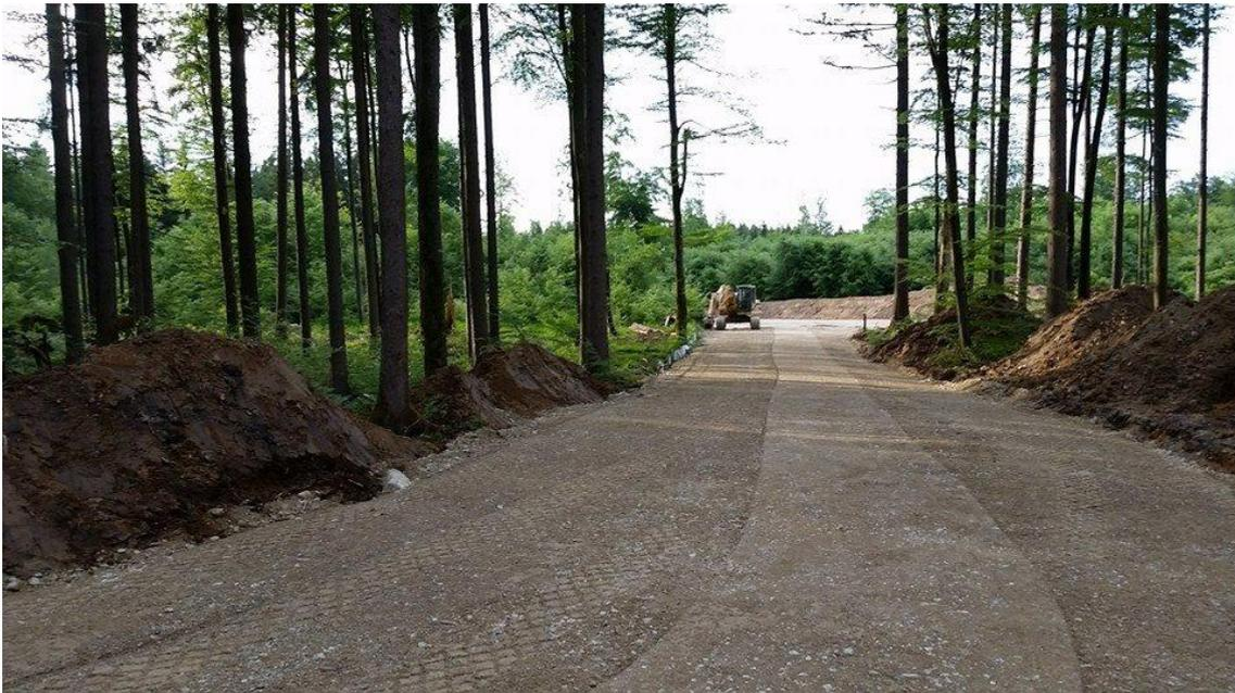
Für den eigentlichen Standort einer Windenergieanlage muss eine Fläche von ca. 3 500 qm gerodet werden. Da die Neigung dieser Fläche auf  $<1\%$  begrenzt ist, müssten aufgrund der Topografie bei den Standorten im Wald erhebliche Eingriffe in Form von Geländeneivellierungen durchgeführt werden. Die ausgebauten Zufahrten und Kranflächen müssen dauerhaft bleiben, da WEA gewartet und repariert werden müssen.
