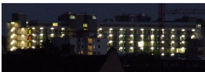
Abbildung 14. Unnötige Nachtbeleuchtung am DKFZ
