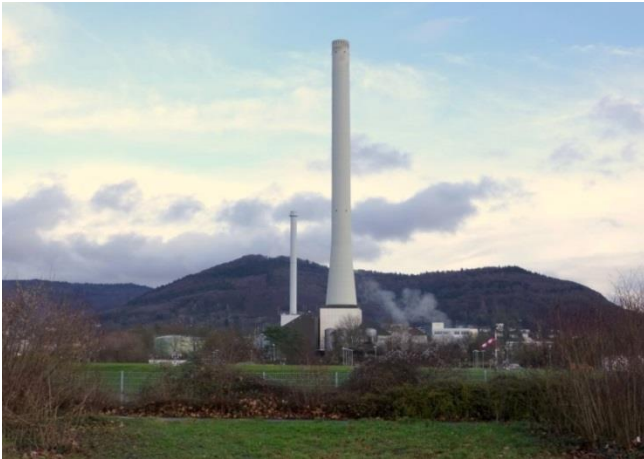
Abbildung 12: Heizwerk (großer Kamin) und neue KWKK-Anlage (kleiner Kamin)
